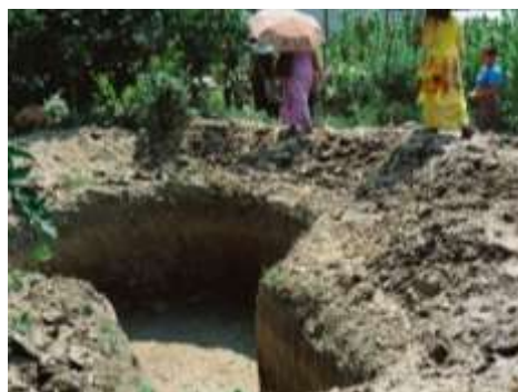
Toilet and bio-gas digester under construction 建造中的化粪池及沼气池
