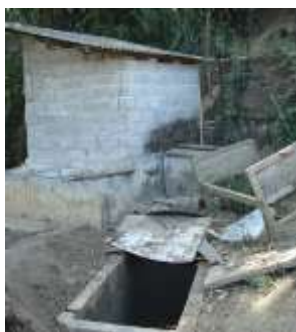
Toilet and bio-gas digester under construction 建造中的化粪池及沼气池
